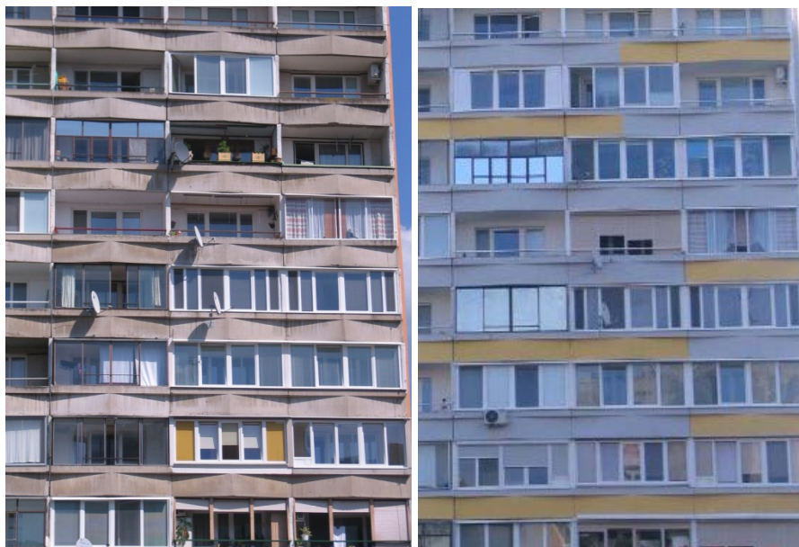
Obr. 8 – Pohľad na časť priečelia panelového bytového domu v Bratislave – Petržalke.
