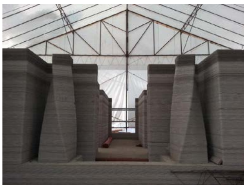
Obr.3– Príklad čerstvých ešte nezatvrdnutých vrstiev na vrchu a spodných už zatvrdnutých vrstiev Zdroj: ALTER J., 2015
