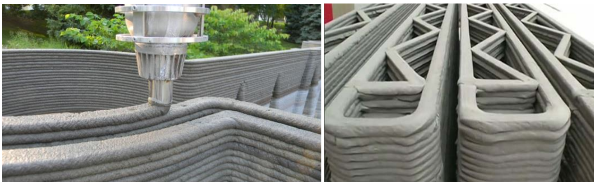
Obr.1– Príklad materiálu a vytlačenej konštrukcie pomocou 3D betónovej tlače
