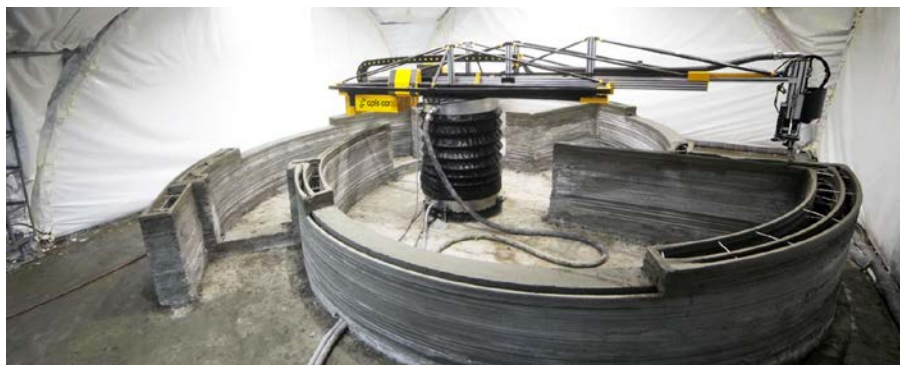
Obr.6 – Príklad procesu výstavby pomocou 3D stavebnej tlačiarne od firmy APIS CORE Zdroj: APIS CORE, 2018
