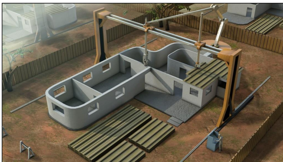
Obr. 2 – 3D tisk budovy
