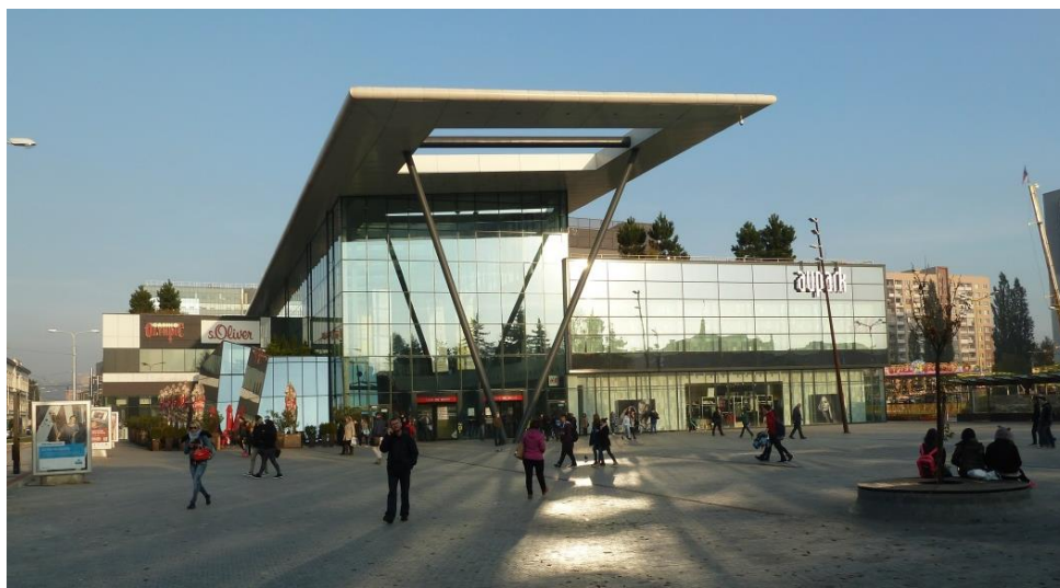
Obr. 7 - Aupark Košice - príklad nákupného centra lokalizovaného v centre mesta
