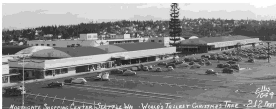
Obr. 4 - Prvé predmestské nákupné centrum na svete - Northgate v Seattli
