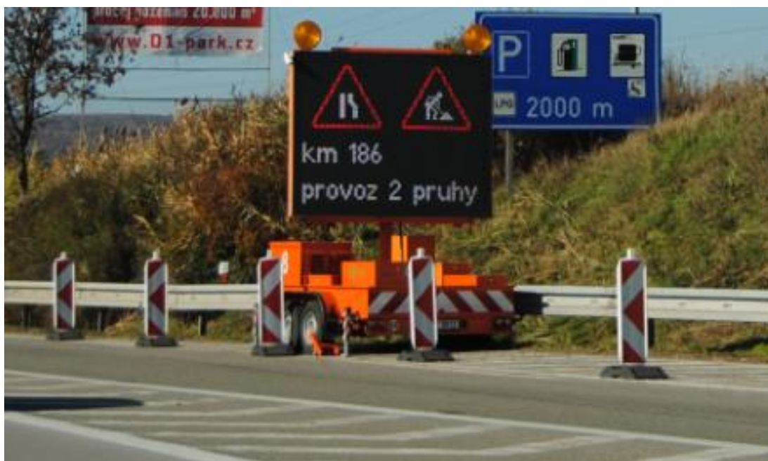
Obr. 2 - Mobilní přechodné proměnné dopravní značení na dálnici D1 Zdroj: HANZL, 2017
