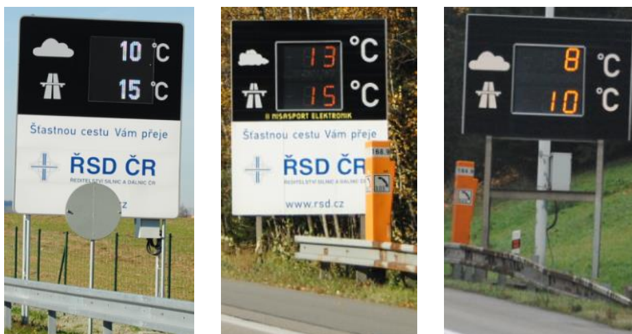
Obr. 4 - Digitální teploměry na dálnici D1 Zdroj: HANZL, 2017
