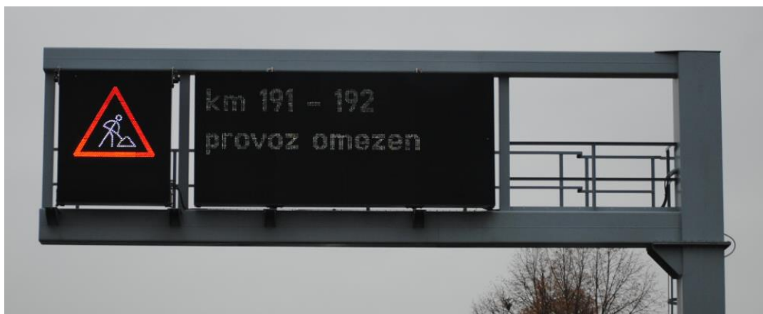
Obr. 3- Proměnná dopravní značka společně se zařízením pro provozní informace na dálnici D1 Zdroj: vlastní
