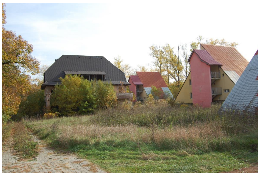
Obr. 6 – Schátralé budovy bývalých ubytovacích zariadení Zdroj: vlastné spracovanie
