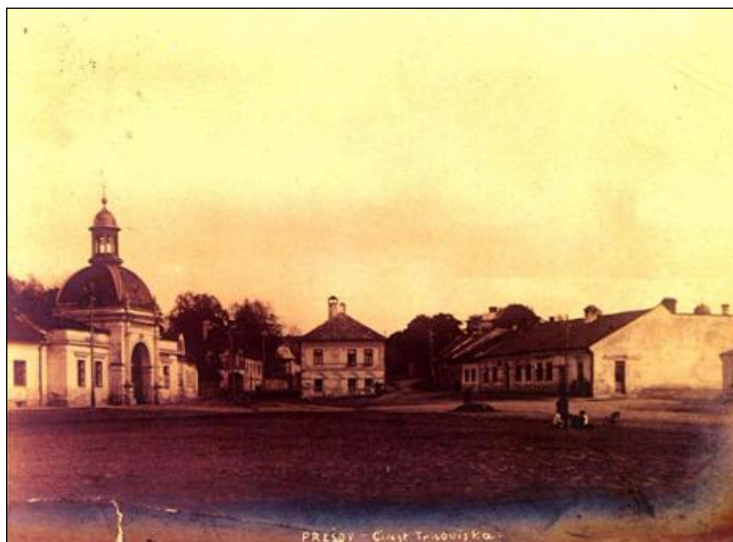
Obr. 6 Pohľad na vstup na cintorín, vľavo stojaca brána so zvonickou
