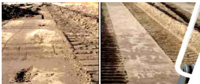
Obrázok 3 – Zrovnávanie terénu prostredníctvom 3D systémov, vľavo – 3D systém, vpravo – systém 3D-MC 2 Zdroj: www.topconpositioning.com
